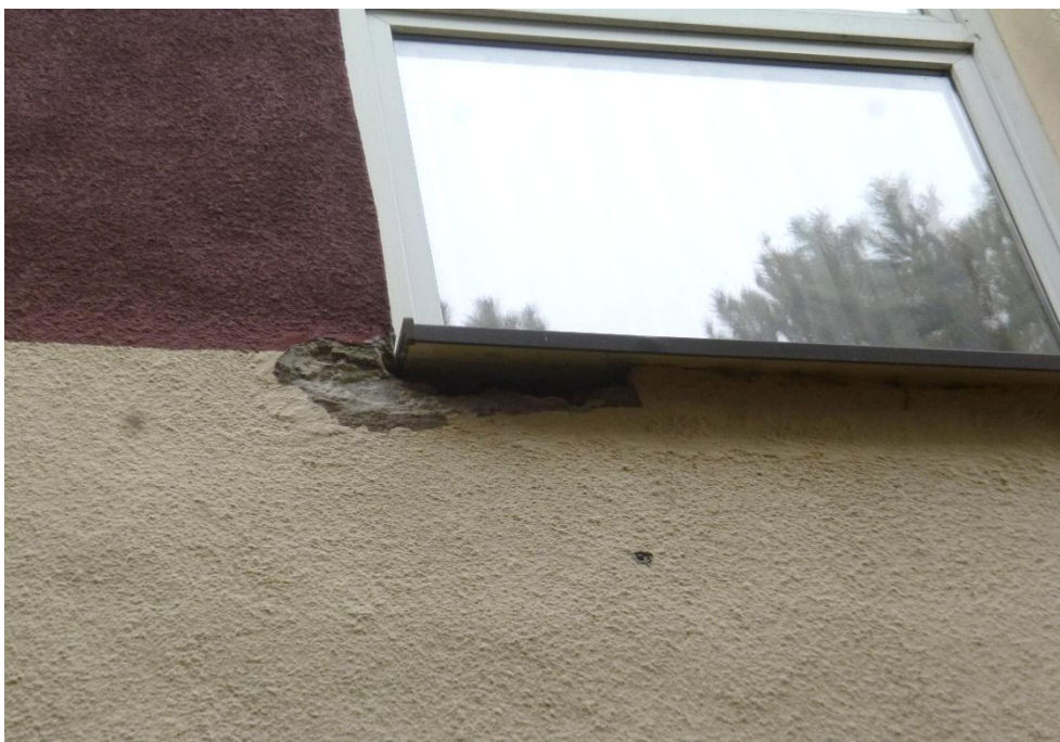
Foto.6. Ubytki pod parapetami okiennymi. Fot. Przemysław Kubacki.
