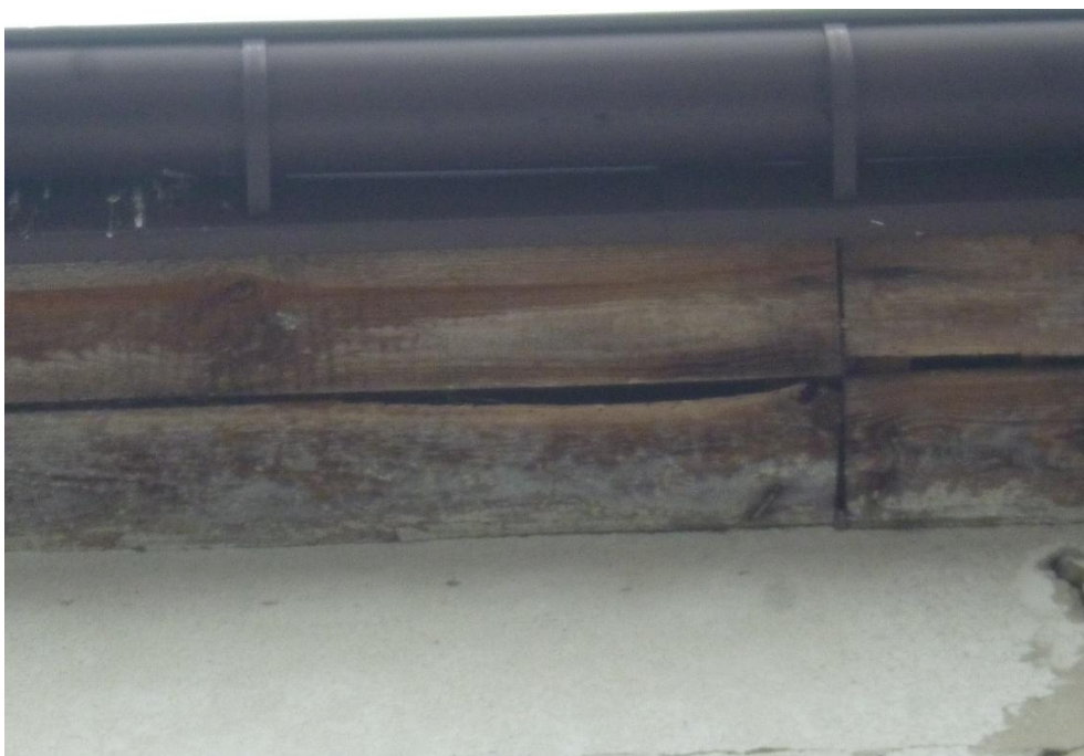
Foto.6. Podbitka zachodniej strony dachu, widoczne wytarcia na łączeniu desek. Fot. Przemysław Kubacki.
